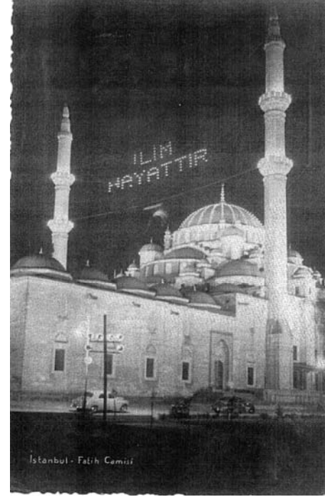
Fatih Camii Avlusu Fevzipasa Caddesi Açılmadan önce ana yol üzerinde olması sebebiyle taşıt trafiğine açıldı
