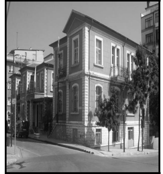
Kent Müzesi olarak kullanılmak üzere restore çalışmaları devam eden eski Konservatuar binası
